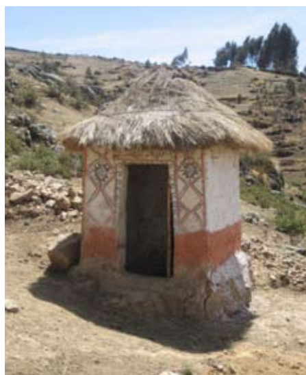
Voor het eerst van hun leven beschikken ruim 800 families over een eigen toilet.
